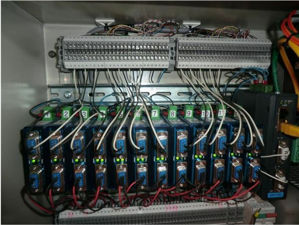
Die auf Hutschienen montierten Interfaces verbinden RS232- und RS422-Schnittstellen.
